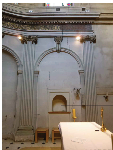
Bâti ancienne porte bois 2 vantaux métal dans niche habillage contreplaqué
