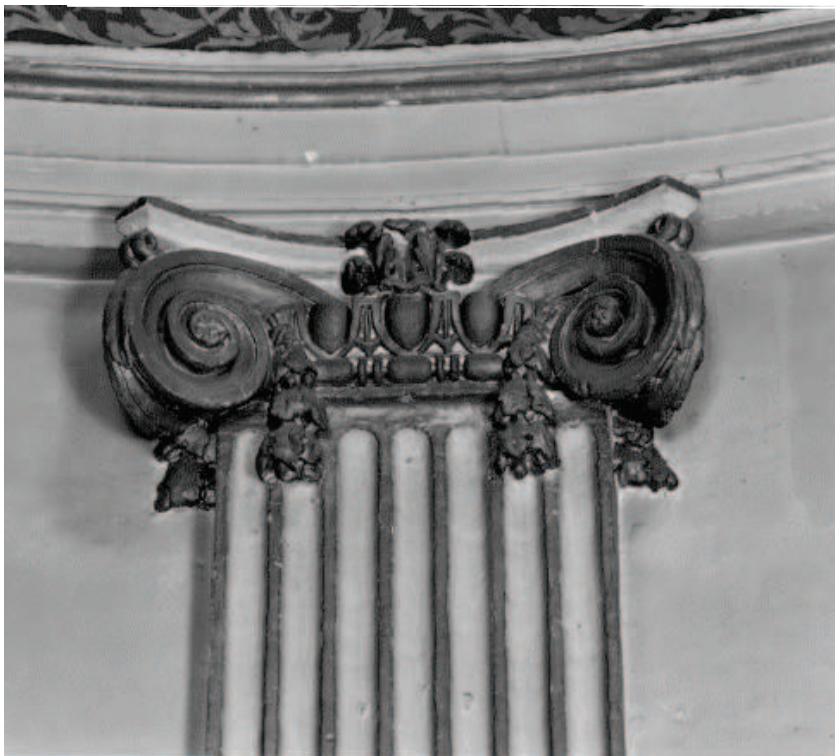
1. Détail d'un pilastre ionique du chœur
